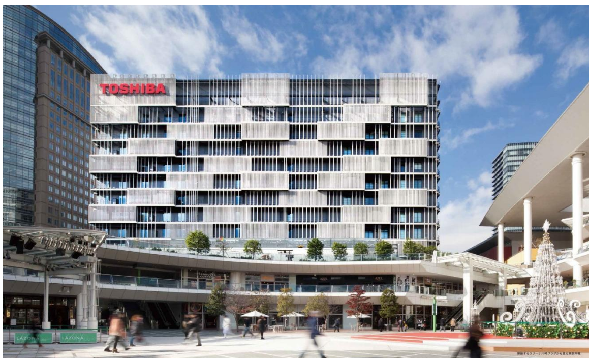
ラゾーナ川崎東芝ビル 外観写真
