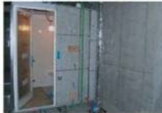
2階ユニットバス取付状況(平成19年3月15日)
