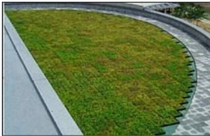
屋上緑化(4F部)
