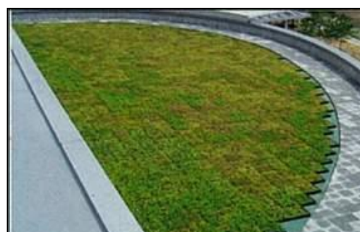
<屋上緑化>参考写真
