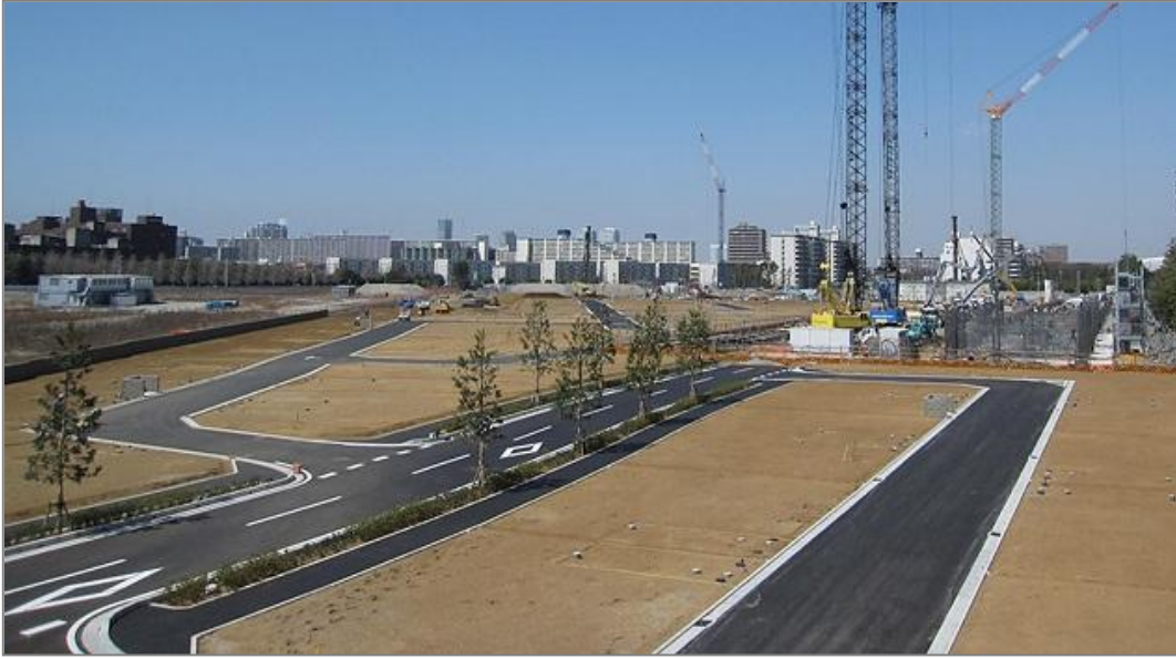
【『プライドシティ稲毛海岸』開発区域内の状況(写真は平成23年4月)】
