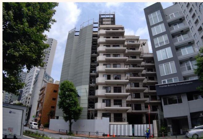
解体工事中の写真
