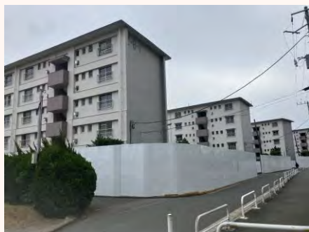
解体工事中の写真
