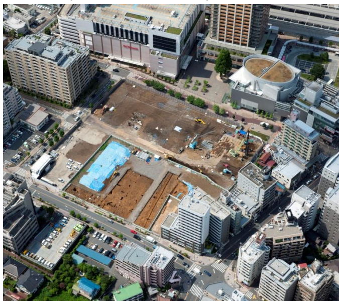
■ 現況写真(平成 29 年 7 月末時点)
