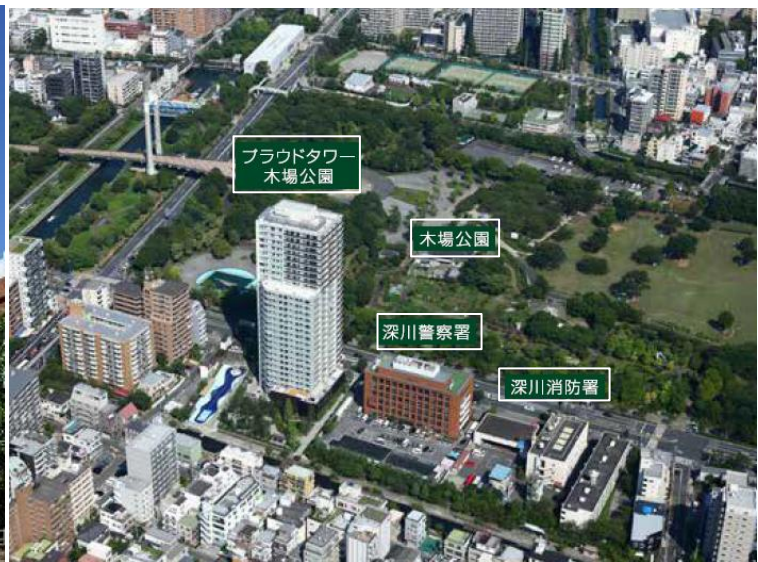
空撮(周辺の安全確認のため、屋上を消防署に開放)
