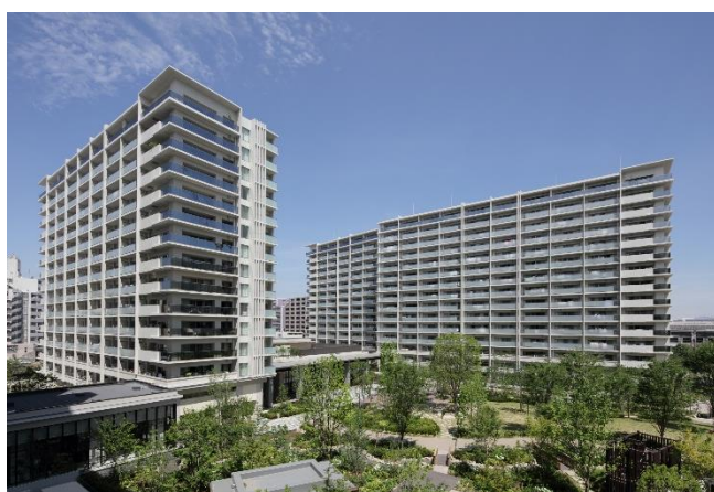
「プラウドシティ塚口」外観
