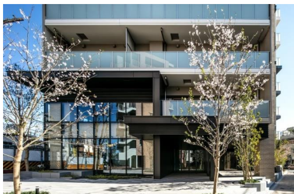
【エントランス外観】
