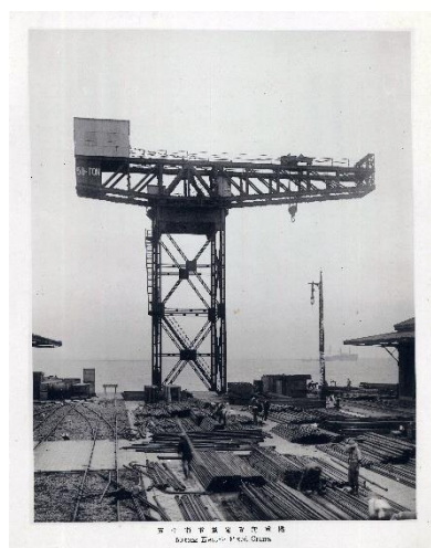
※1 完成したハンマーヘッドクレーン 1917年(大正6)年
