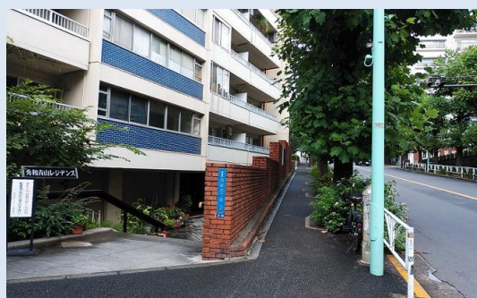
【現在の敷地南東側】
