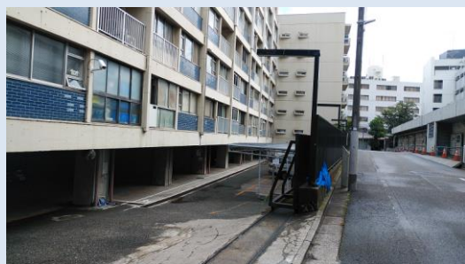
【現在の敷地北西側】
