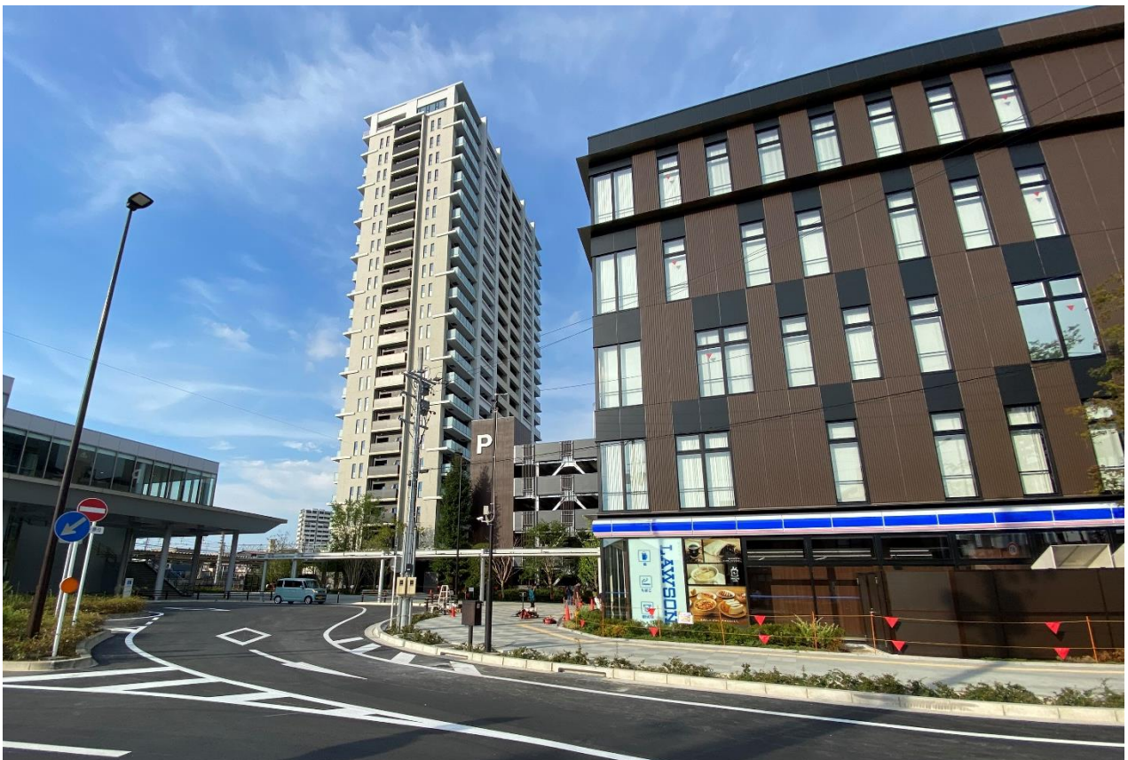
竣工写真（南西より区域全体）
