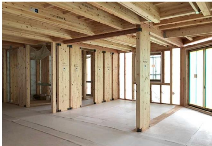
2階：事務所部分 （建築中の様子）
