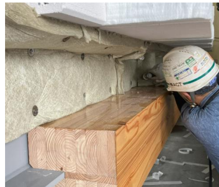
H 形鋼の下端に集成材を挟み込む構成により、鉄骨の補剛と耐火被覆を併せ持つ部材。集成材が被らない範囲は、無機繊維フェルトにて被覆
