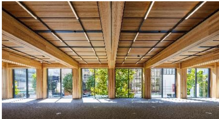
野村不動産溜池山王ビル 無柱の木質オフィス空間
