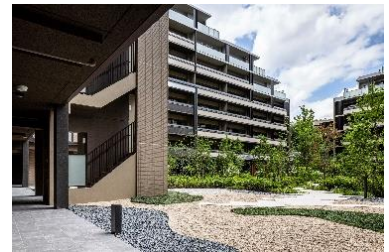
【非舗装の砂利を採用した中庭管理通路】
