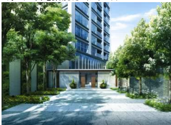
<オートロックを採用したメインゲート>
