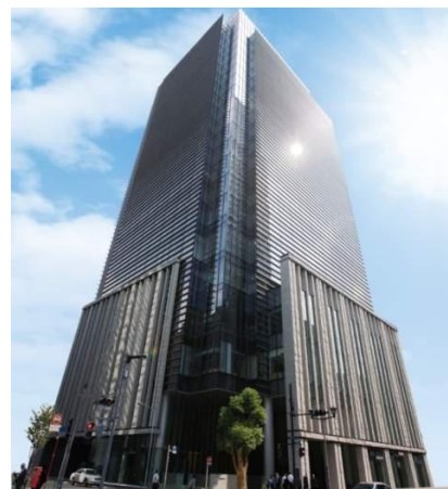
日本橋室町野村ビル外観
