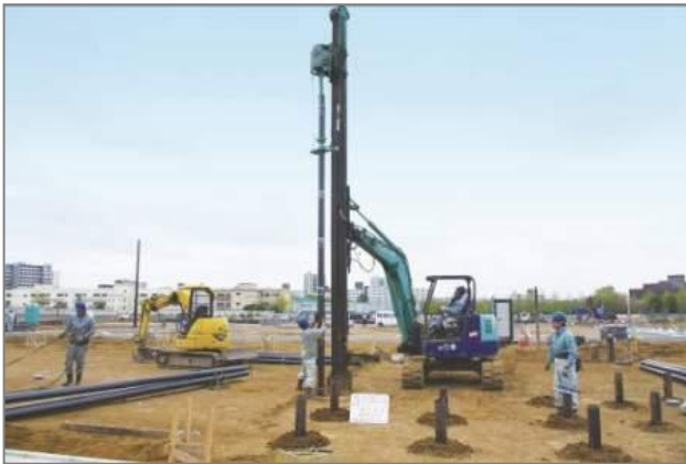
【「ガチラ工法」参考写真】
