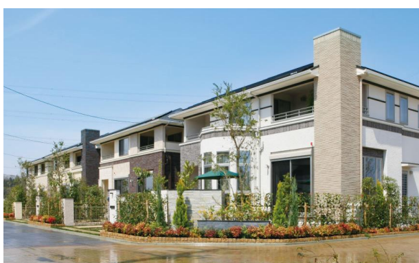
「ファインコートけいはんな公園都市」街並み写真 (三井不動産・三井不動産レジデンシャル)
