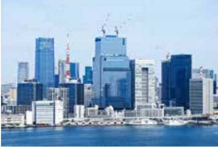
S棟の工事状況(2024年5月下旬時点)
