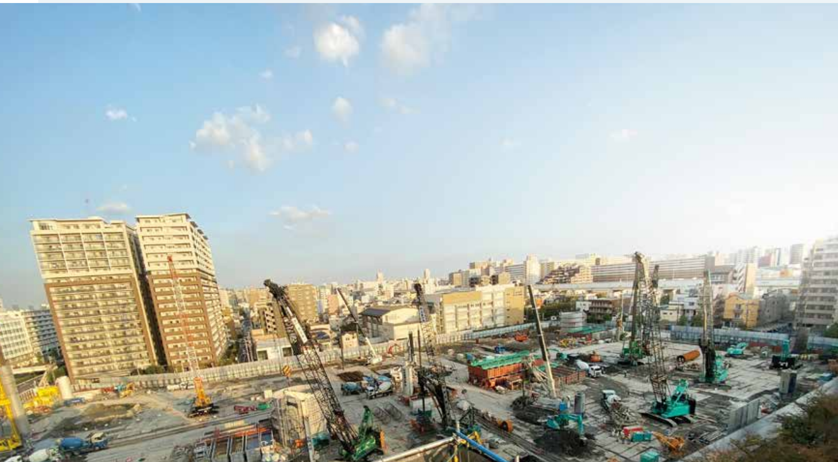
「亀戸プロジェクト」建設中の様子
