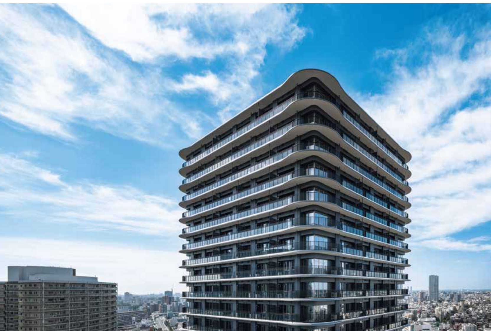
建物外観 プラウドタワー目黒MARC
