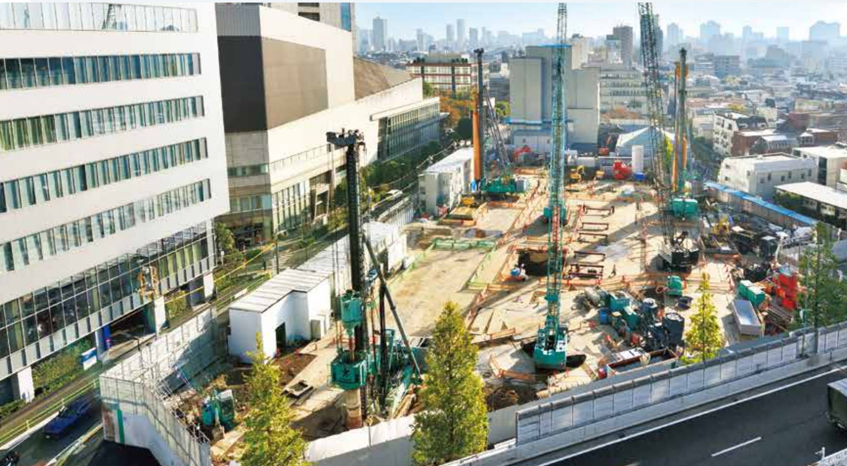
「西麻布三丁目北東地区第一種市街地再開発事業」工事中の様子
