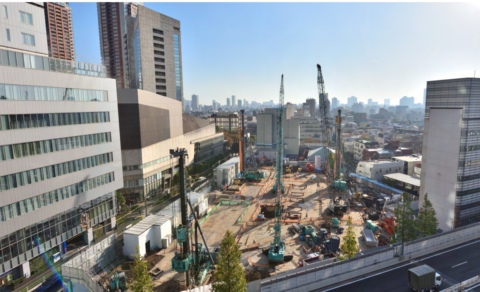
「西麻布三丁目北東地区第一種市街地再開発事業」工事の様子
