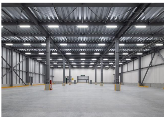
2 階倉庫エリア
