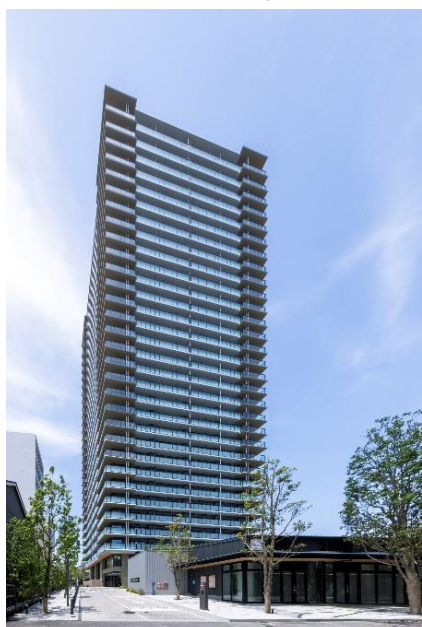
【竣工建物写真(南東面)】
